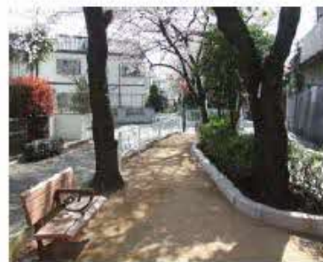
舗装の改修による平坦な歩 行空間整備・休息スポット としてのベンチ設置
