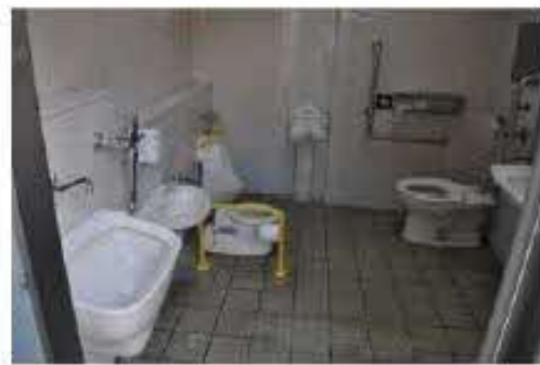
バリアフリースイレ 室内で車いす回転可能。 オストメイトやベビー用 トイレ等も設置される。
