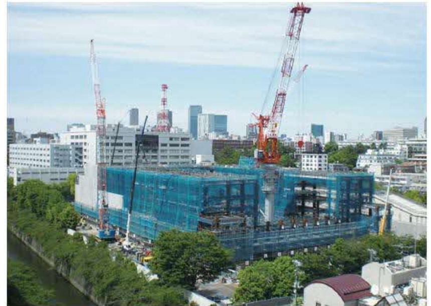
建設工事の全景(目黒清掃工場)
