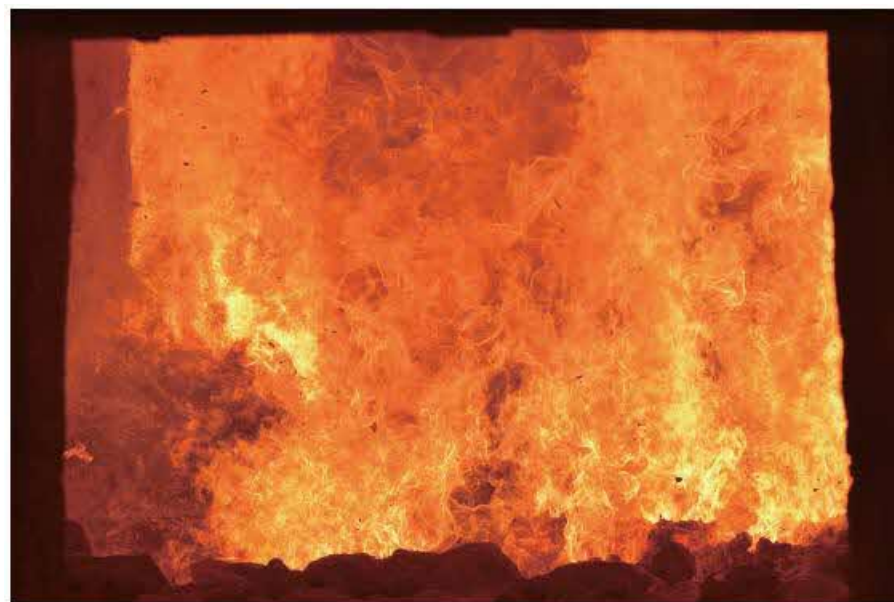
焼却炉内部の様子 (杉並清掃工場)
