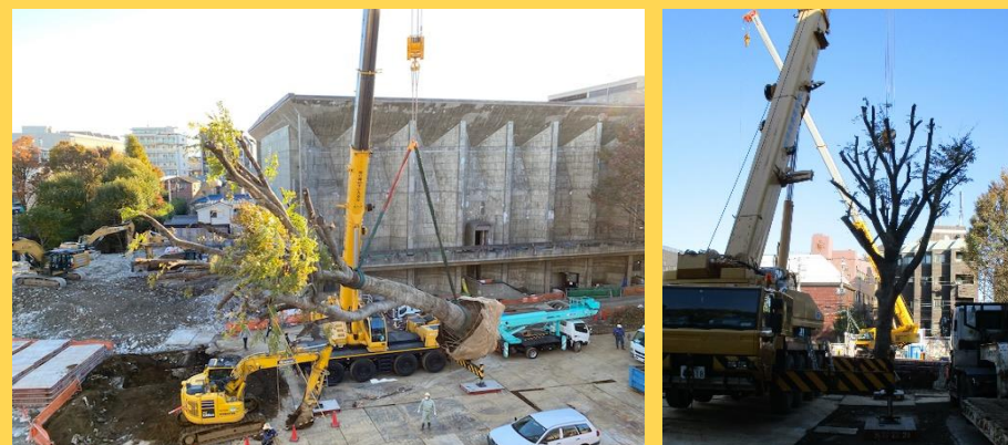
大型重機を使用して、ケヤキを新しい移植場所に移動しました。(令和3年11月)
