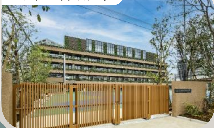
池袋第一小学校改築工事
