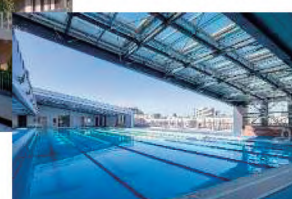
▼北区立都の北学園屋上プール施設竣工写真
